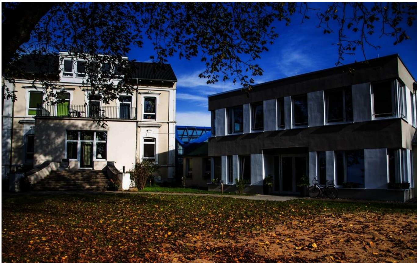
Abbildung: Außenansicht Neubau und Villa der Fachklinik Bokholt.
